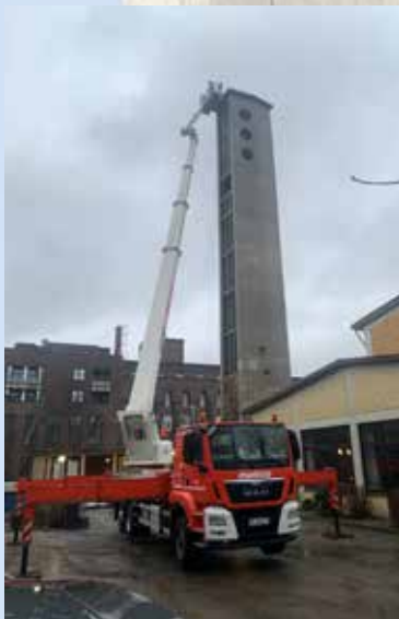
St. Johannis: Blitzschutz für den maroden Kirchturm
