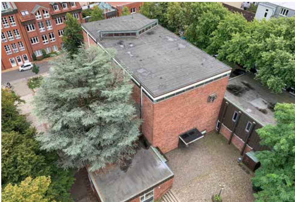
Blick vom Turm der Dreifaltigkeitskirche auf das Kirchenschiff
