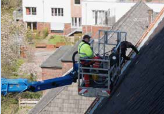
St. Paulus: Dachreparatur
