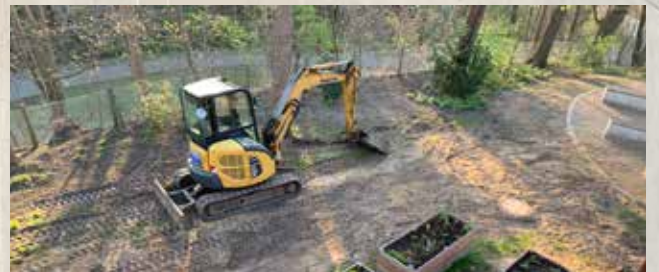
Luther: neue Abwasserleitungen
