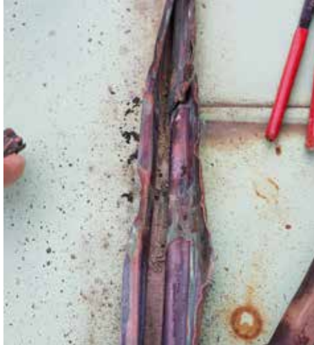
Durch Fugen im Kupferdach drang Wasser ein. Die Dachplatten darunter sind rostig und bröckeln.
