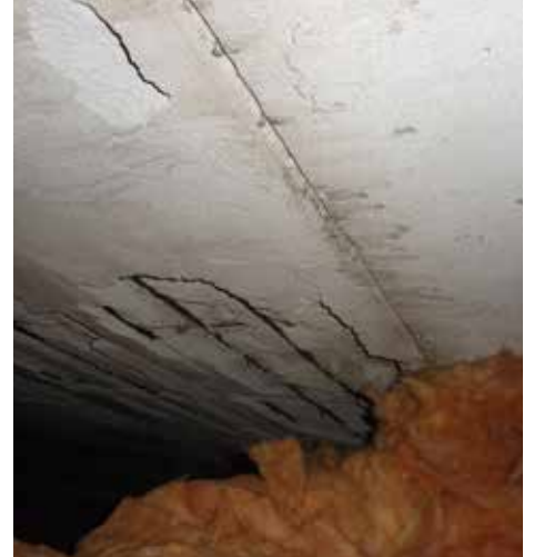
Durch Fugen im Kupferdach drang Wasser ein. Die Dachplatten darunter sind rostig und bröckeln.
